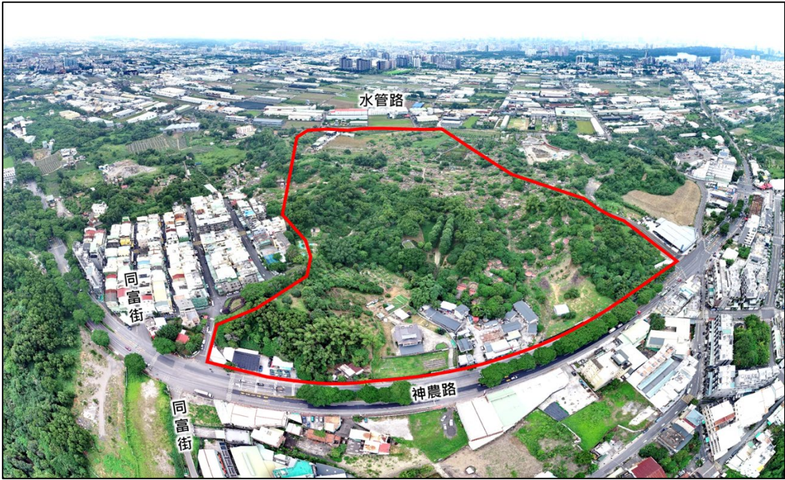
捷運黃線 Y1 機廠站現況
