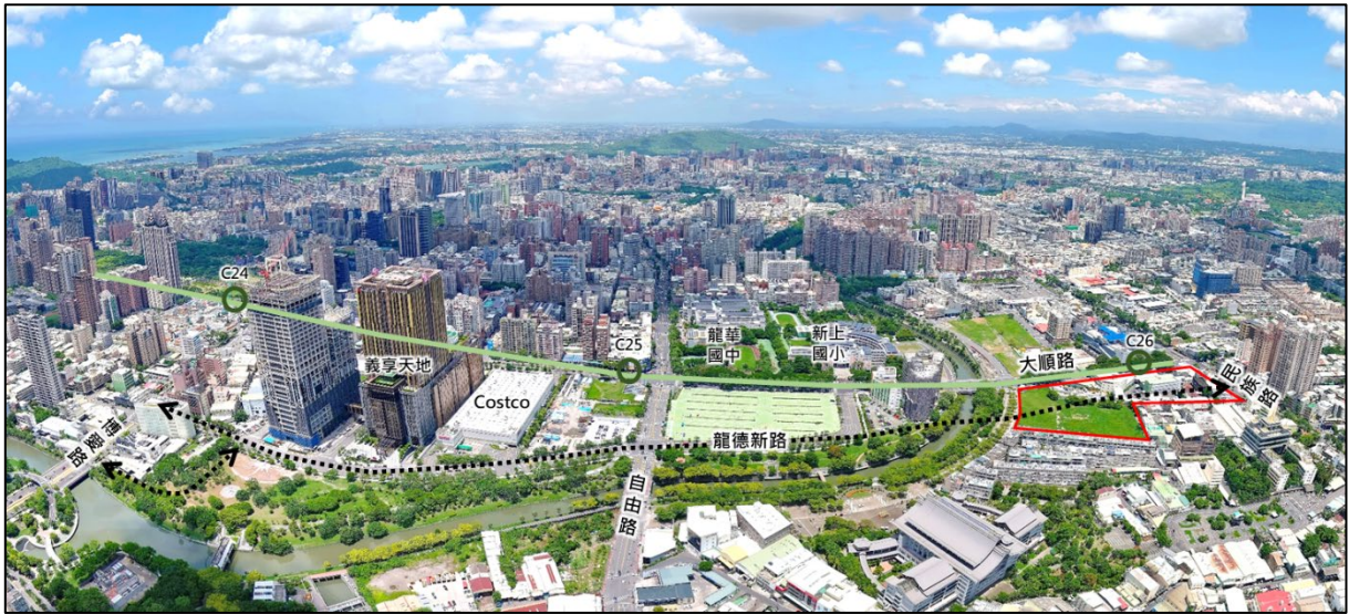
龍德新路現況
