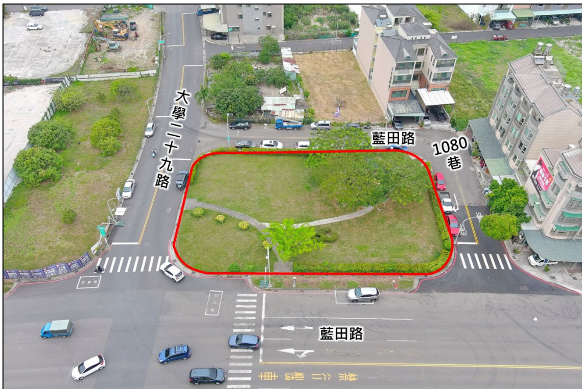
楠梓援中派出所新建基地現況
