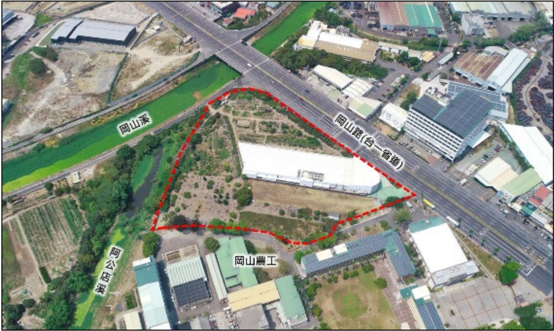
RK2 捷運開發區現況
