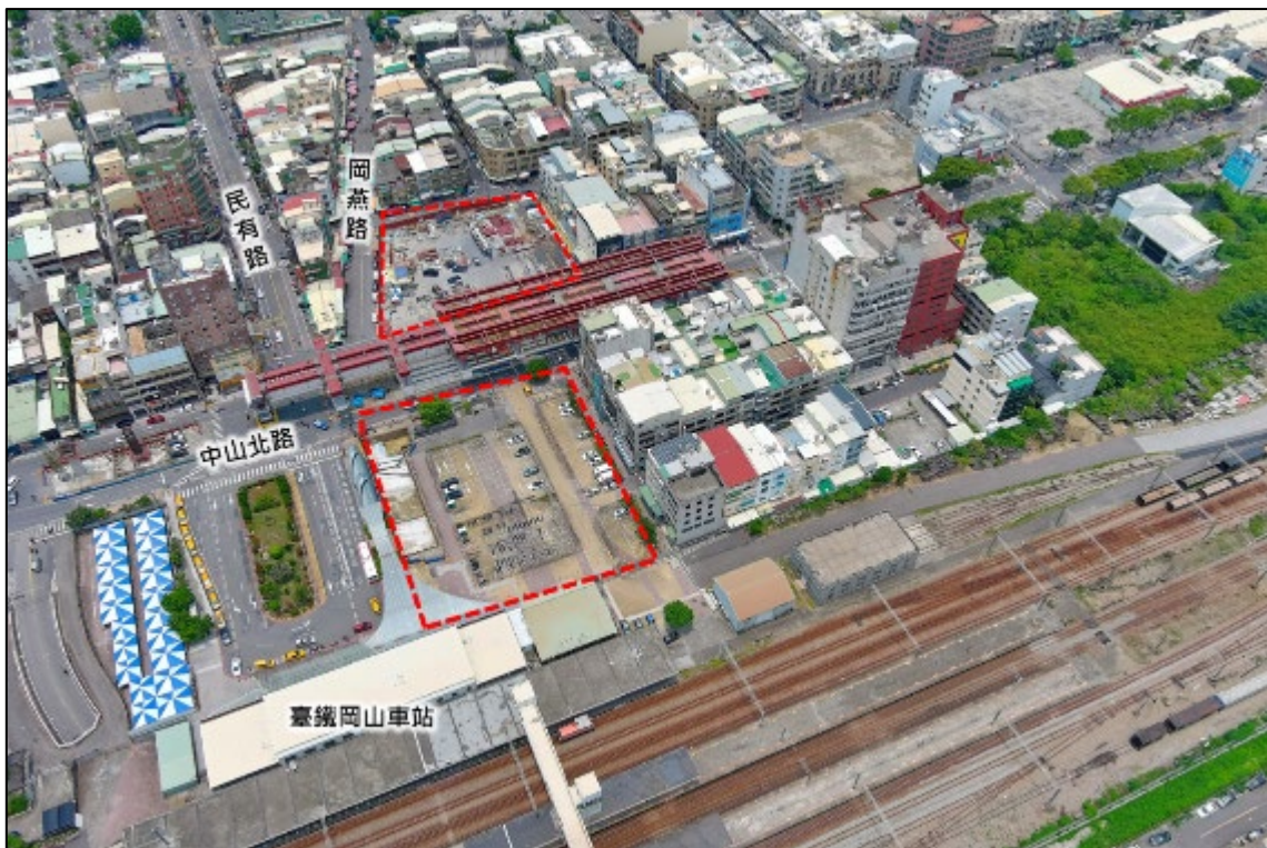
RK1 捷運開發區現況
