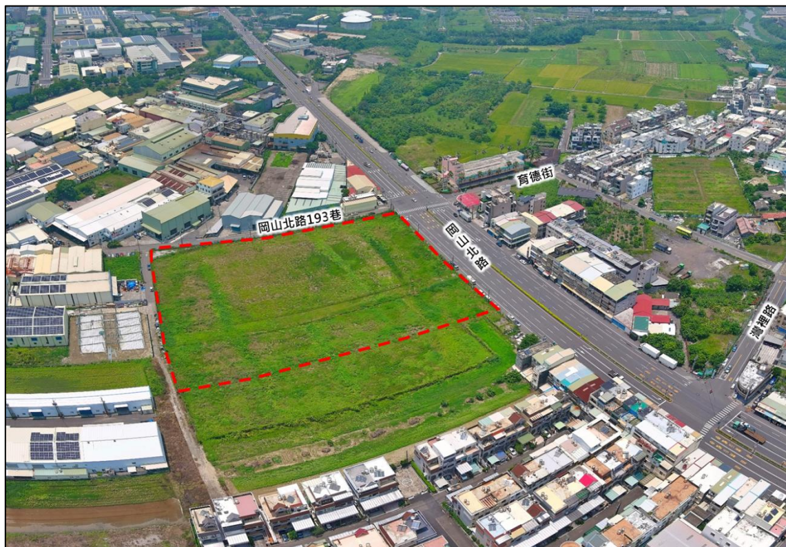
RK3 本洲產業園區站西側聯合開發基地現況
